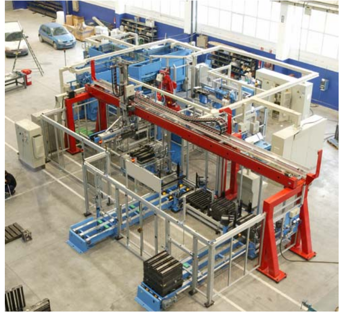
Parte de la instalación
