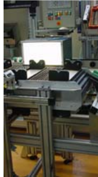
Estación de identificación por visión
